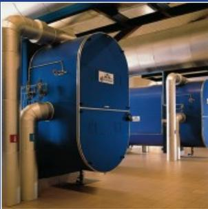
Danstoker hat weltweit mehr als 2500 Abgaskessel geliefert. Die Kessel werden Gas - oder Dieselmotoren nachgeschaltet.
