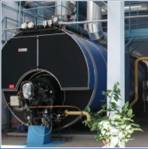
Die Entwicklung und Herstellung von hocheffizienten Öl- und Gas-kesseln für den Energiesektor haben Danstoker eine Position unter den führenden, europäischen Kesselherstellern verschafft. Die Leistungen reichen von 800 bis 50.000 kW sowie Dampfleistungen von 0,2 bis 68 t/h Dampf. Zulässiger Betriebsüberdruck bis zu 43 barü und bis 450°C Überhitzung.
